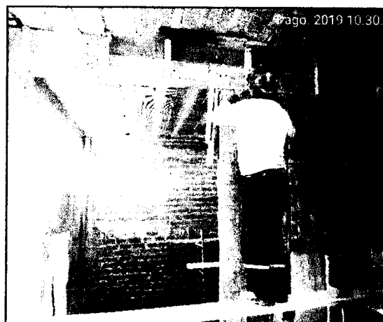
Foto N° 09 y 10: Desencofrado en area de losa aligerada del primer nivel del area de Administración.
