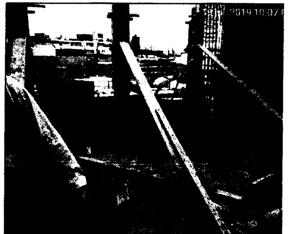
Foto N° 05 y 06: Encofrado vaciado y desencofrado de columnas y columnetas del area administrativa
