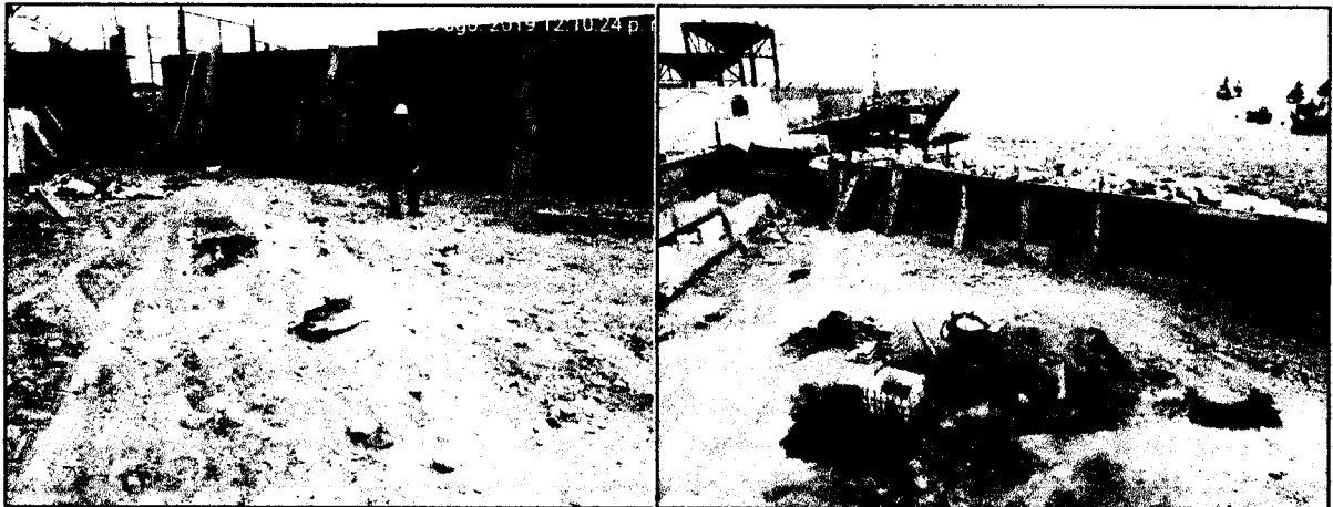
Foto N° 15: Partida N° 01.09.07 "PTAR", 01.09.07.01 "movimiento de tierra", que intentaron sorprender ser valorizadas sin ejecutar: en este sentido se muestra fotos del area donde se construira la PTAR, no viendose excavaicion alguna, mucho menos eliminacion de excavación
