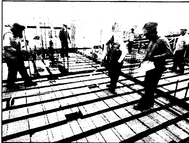
Foto N° 03 y 04: Colocación de ladrillo hueco de arcilla para construcción de losa aligerada, instalación de tubería y cajas de electricidad, para luminaria y tomacorrientes, del area administrativa
